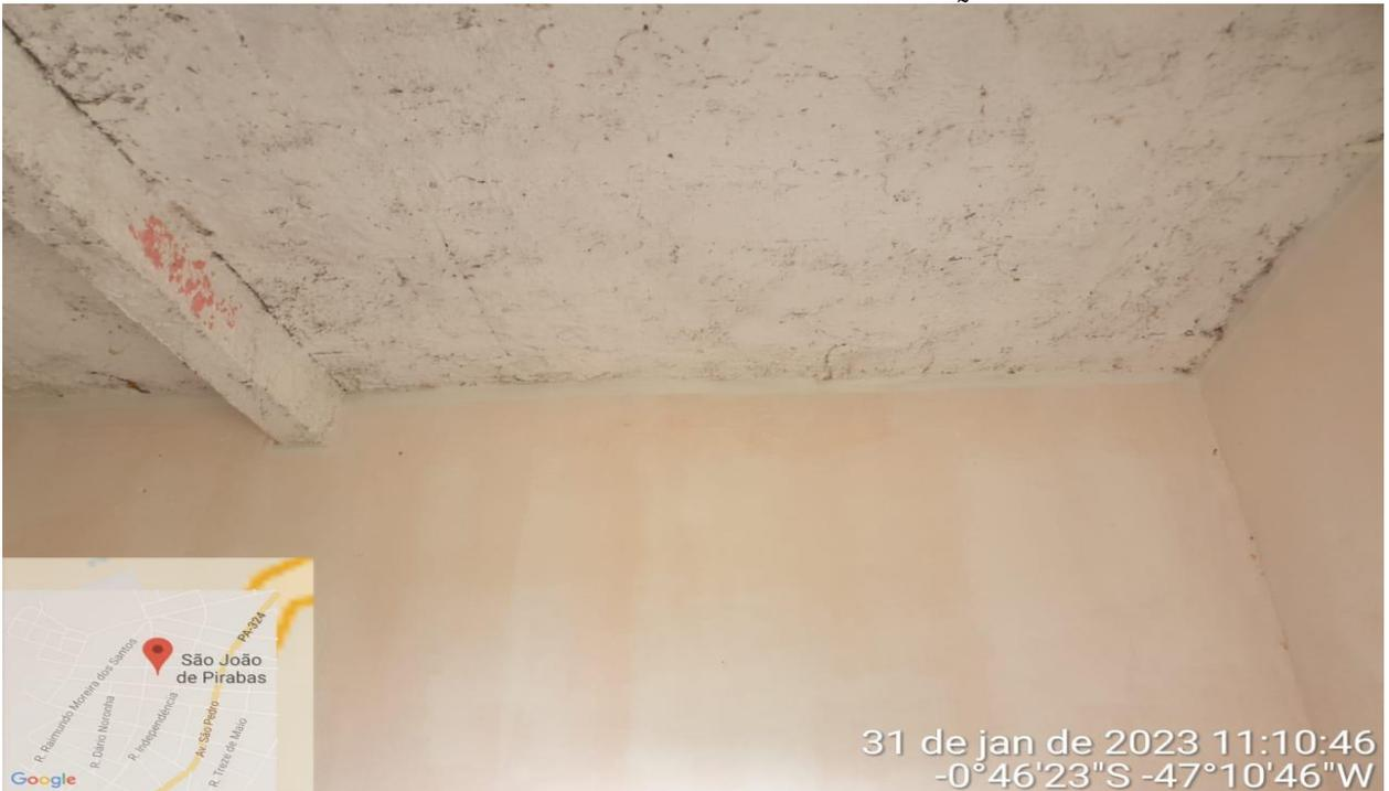
FOTO 05: FORRO EM LAJE DE CONCRETO ARMADO.
