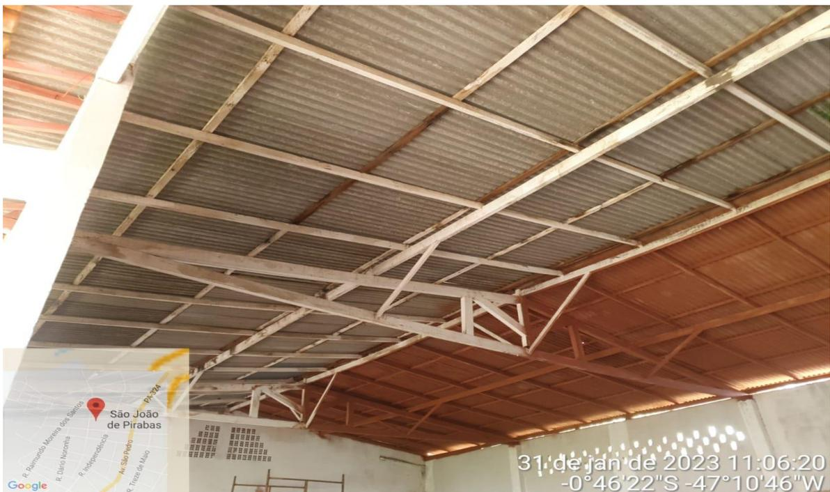
FOTO 08: PINTURA DA COBERTURA - TELHA DE FIBROCIMENTO.
