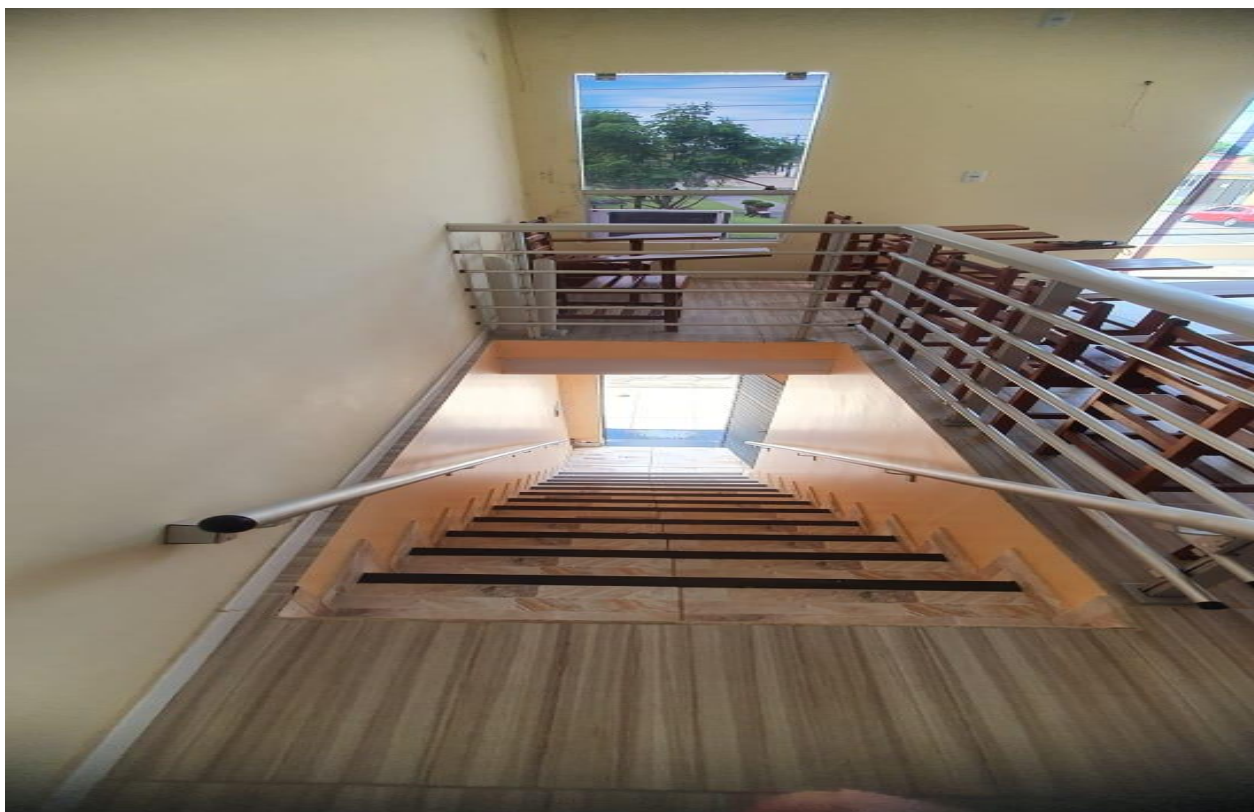
FOTO 06: ESCADA DE ACESSO COM GUARDA-COPO EM ALUMÍNIO.
