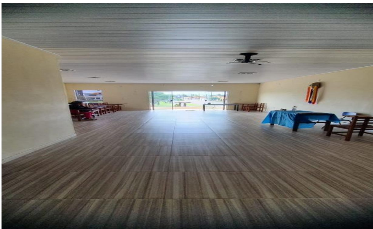
FOTO 02: SALÃO – PISO CERÂMICO / ESQUADRIA DE ALUMÍNIO/VIDRO/FORRO PVC
